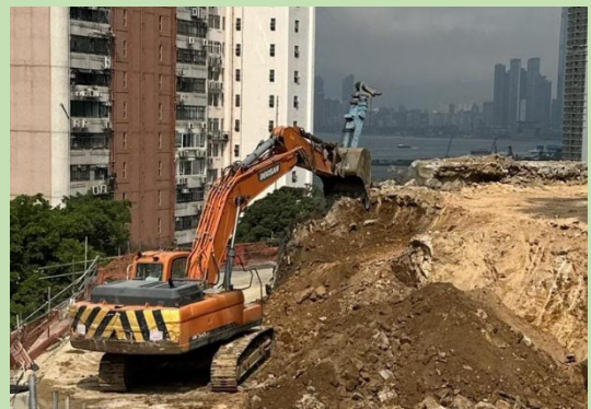
削坡工程 Slope Cutting
